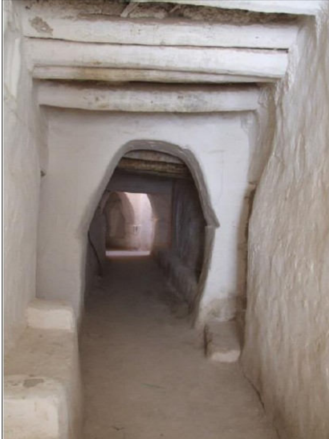
Figure 3 : Une rue couverte pourvue de banquettes
