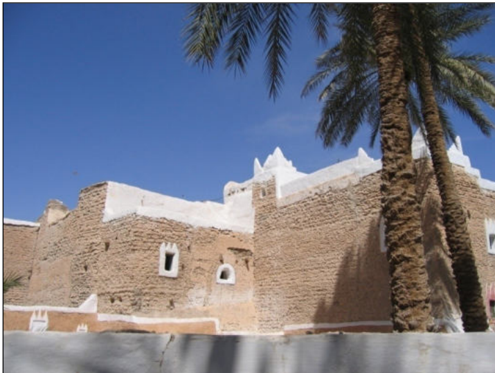
Figure 8 : Extérieurement la maison présente un haut mur en terre percé de petites lucarnes
